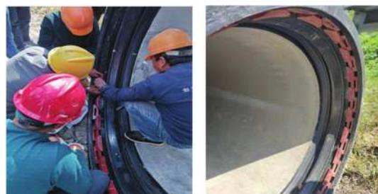
清理干净并捏成心脏形或“8”字形安放在承口内。顶推管子使之插入承口、依次将挡环和压兰推向止推焊环,当挡环接触到止推焊环时,挡环楔形一侧嵌入压兰中,另一侧与止推焊环接触。调整压兰与管道之间的间隙,使沿管道周围的挡环与焊环的接触均匀。管道回填土时,应防止管道中心线位移或损坏管道,管道两侧用人工同步回填直至管顶500mm以上,在管顶以上500mm之内,不得回填大于100mm的土块及杂物。
