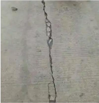
图2 大体积混凝土温差裂缝
