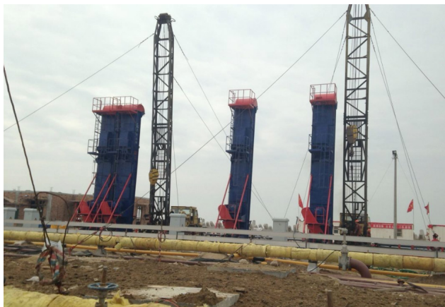
图1 油田地面建设
