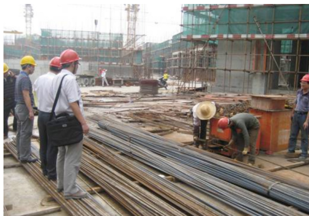
图2 工程施工审查
