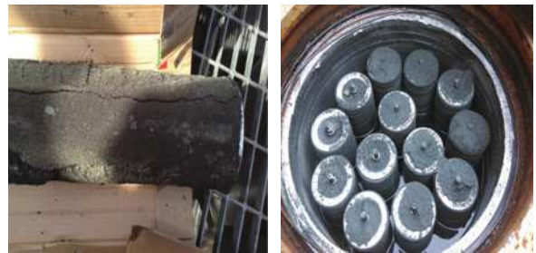
图1-1 原料气过滤器现场拆开滤芯
