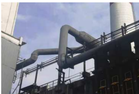
图10 改造后除尘干管图
