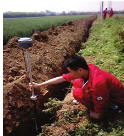
(采用开挖直埋方式施工过程中的RTK定位)
