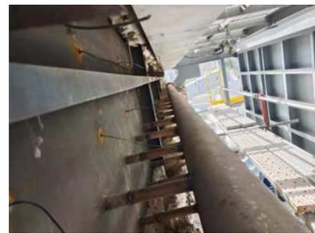
图 6 喷氨格栅改造前后照片(左图为改造前右图为改造后)
