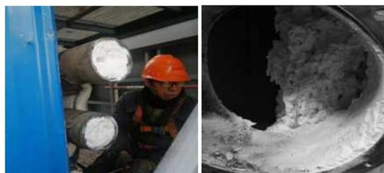
图 1 热解炉及喷氨格栅堵塞
