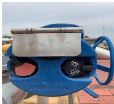
图 7 阀门执行机构显示屏防晒设施
