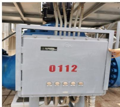
图 6 调压阀控制箱防水设施
