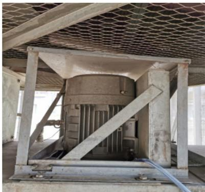
图 4 CAT 发动机空冷器电机防水设施
