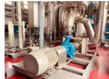
图 3-3 循环热水系统及循环热水泵
