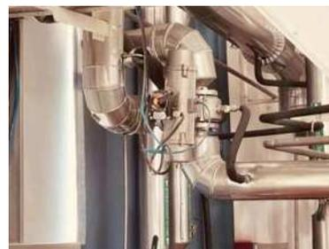
图 3-2 气动三通阀门及循环管道
