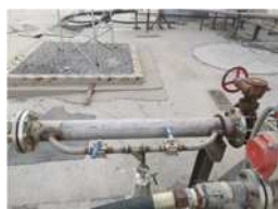
图 4 取样装置安装实物图
