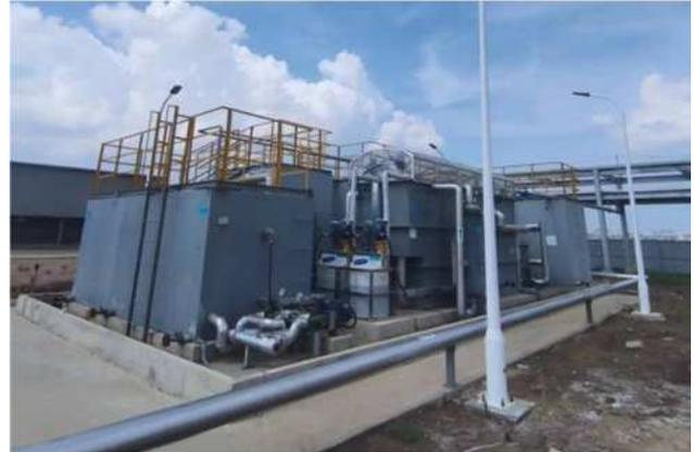
图 3-1 含油废水处理设施现场图
