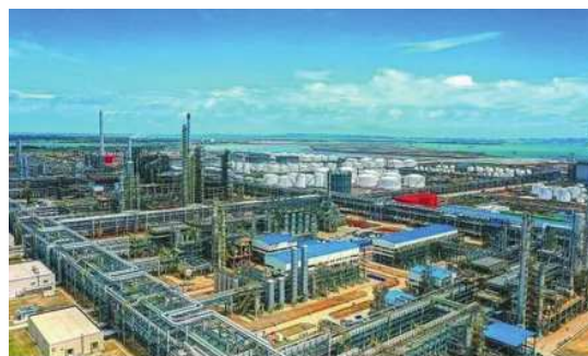
图2 炼化企业施工现场
