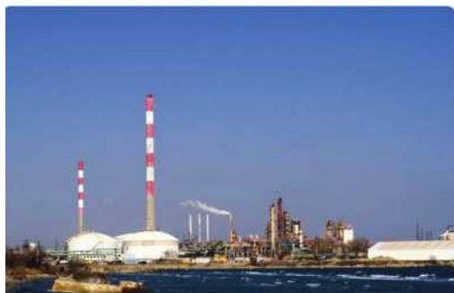
图1 某海上石油企业在建现场
