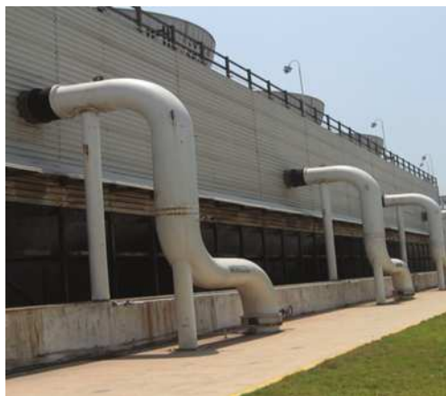
图2 管道与管口直连型
