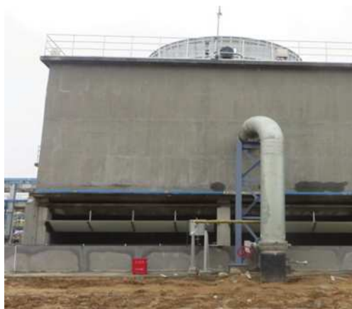
图3 管道与管口错开型
