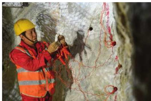
图1 电子雷管引爆作业
