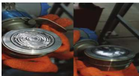
图一 故障变送器解体后膜片照片
