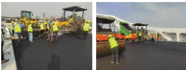
图10 SMA-13沥青混合料摊铺
