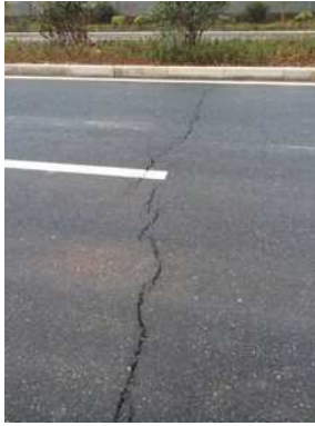
图1 纵向裂缝
