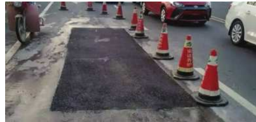
图2 路面坑槽
