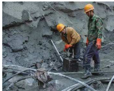
软土路基注浆
