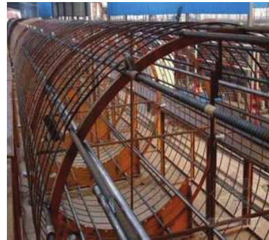
图2 钻孔灌注桩钢筋笼质量控制
