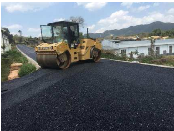
图二: 施工过程中严格控制施工质量
