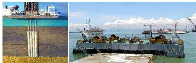
图 1 挤密砂桩与尚未下沉的沉管图
