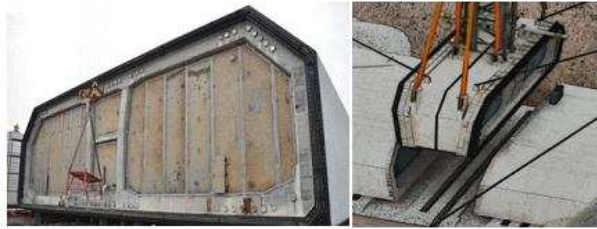
图 2 沉管接头处的止水带示意
