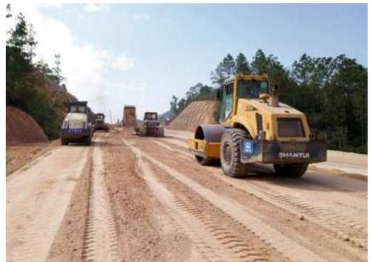
图 1 土路基压实施工现场
