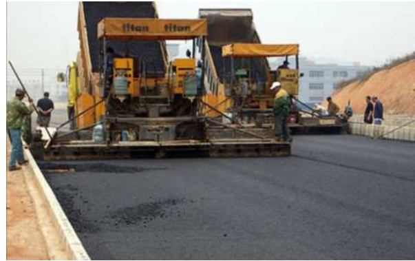
图 1 混合料施工图
