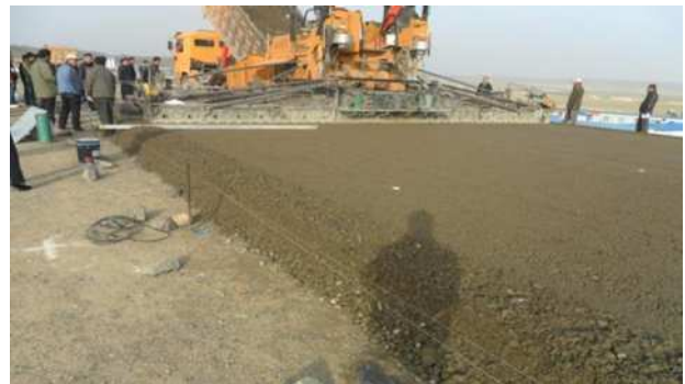
图 2 混合料施工图
