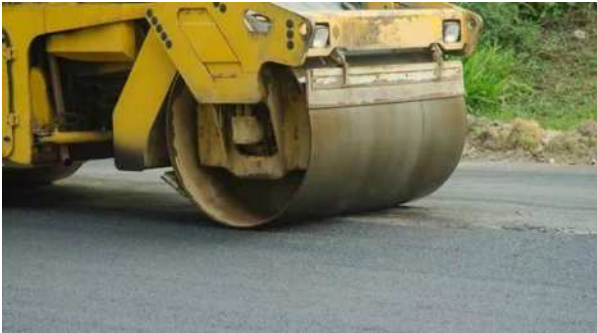
图 3 碾压浇筑施工图
