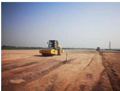
图 1 土路基压实施工图
