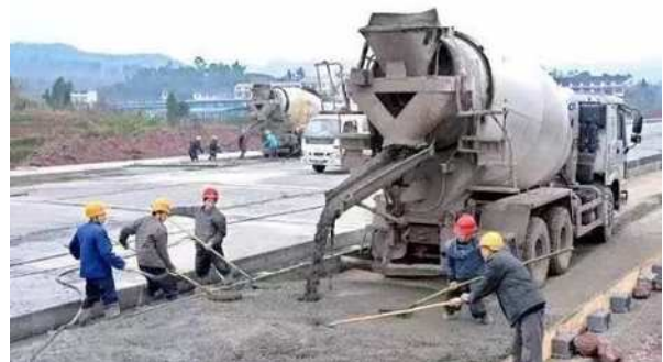
图2 混凝土路面浇筑施工图
