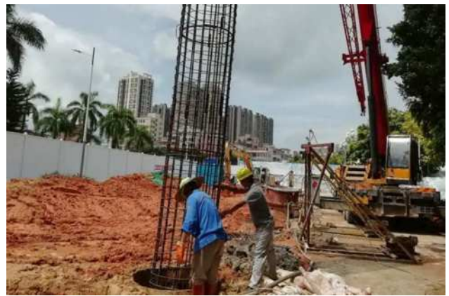
图1 钢筋笼放置现场图
