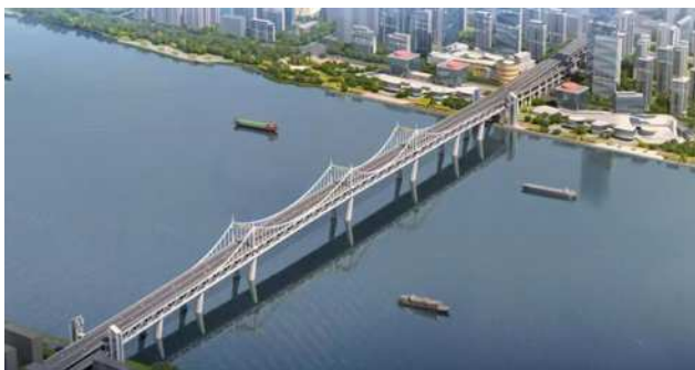
图1 温州市域铁路S3线永宁大桥
