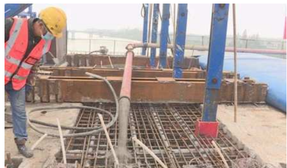
图2 市域桥梁现场浇筑施工图
