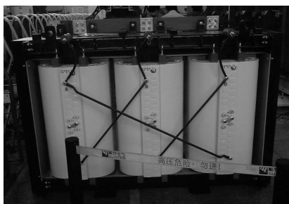
图1 非晶合金变压器
