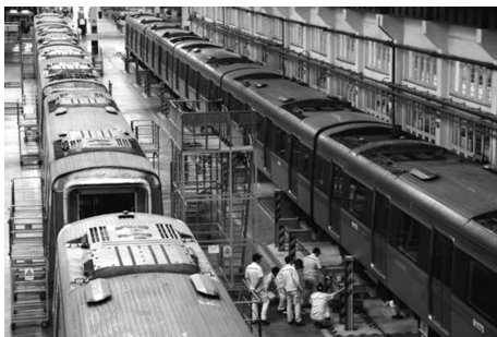
图2 地铁设备检修
