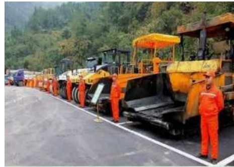
图1 干线公路养护作业现场图示
