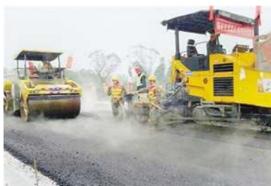
图1 现场摊铺施工
