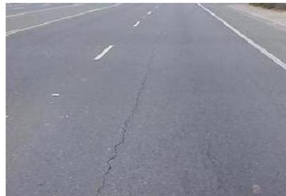
图 9 纵向裂缝
