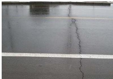
图 8 横向裂缝
