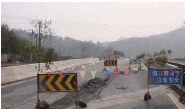
图1 公路路基路面施工现场图
