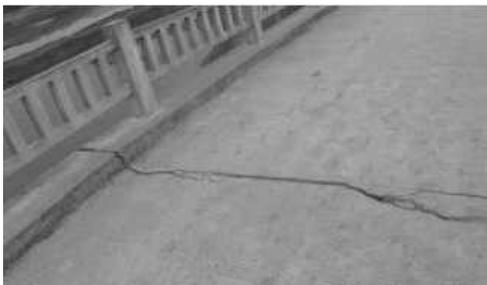
图1 桥梁常见裂缝
