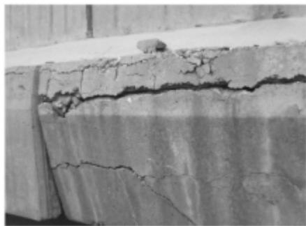
图1 桥梁混凝土裂缝
