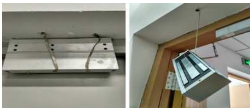
图3 磁力锁防坠落措施
