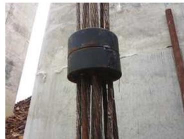
图9 预埋钢绞线与上端钢绞线连接
