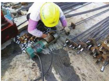
图7 预埋钢绞线锚固端制作
