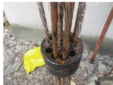
图10 连接器锚固细部图
