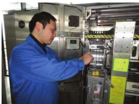
图1 地铁车站AFC设备运维
