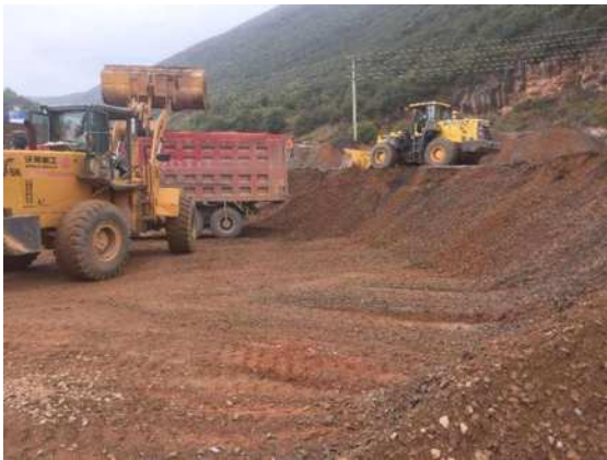
图一: 提前计划沙石用量、完成级配层所需级配料的采购 闷料工作
