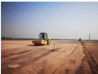
图 1 土路基压实施工图
