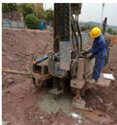
图3 粉喷桩技术施工图
