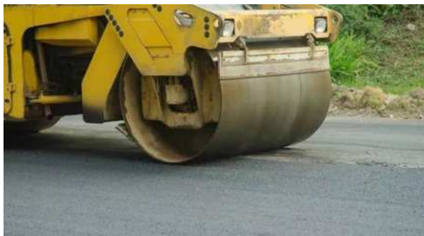
图 3 碾压浇筑施工图
