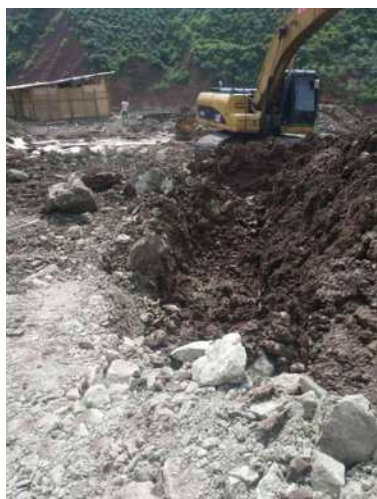
图2 土路基开挖晾晒、换填施工图
