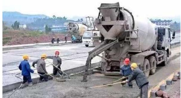
图2 混凝土路面浇筑施工图
