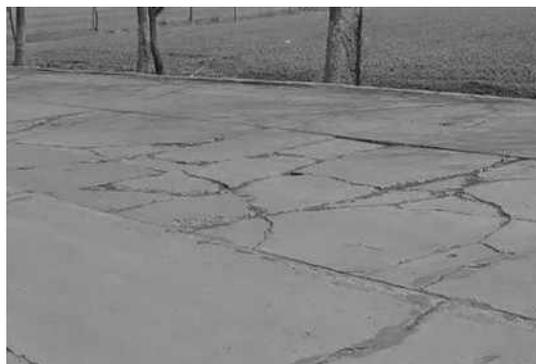
图 1 混凝土路面开裂图
