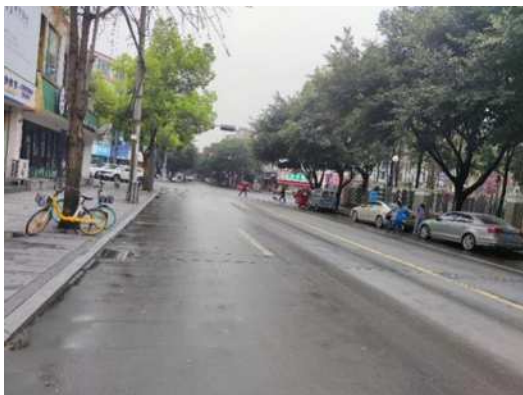
图一 现状混凝土路面
