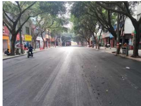
图二 施工后超薄沥青罩面
