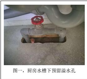
图一, 厨房水槽下预留溢水孔
