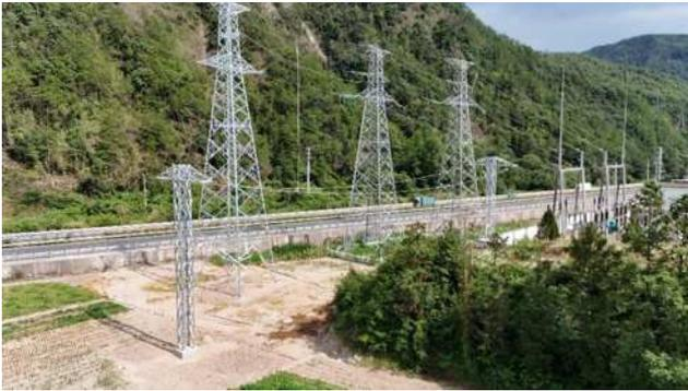
图 7 新建搭接线路 G01 塔及 GZ01、GZ02 单柱 (图中左侧)
