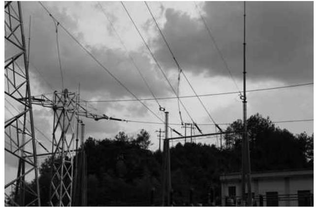
图 11 利用单柱进行跳线搭接放大图
