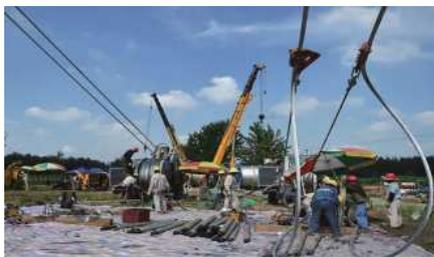
图1 放线施工示意图
