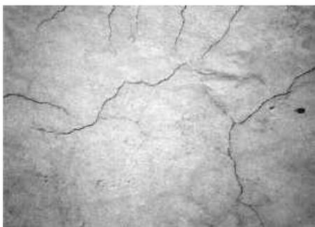
图2 混凝土出现裂缝
