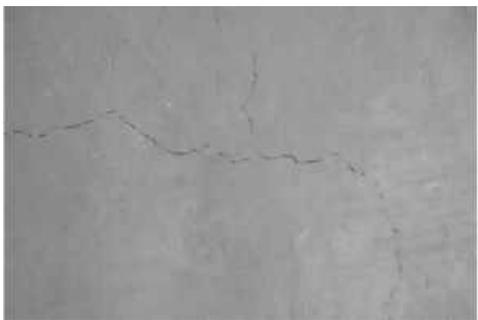
图1 温度裂缝
