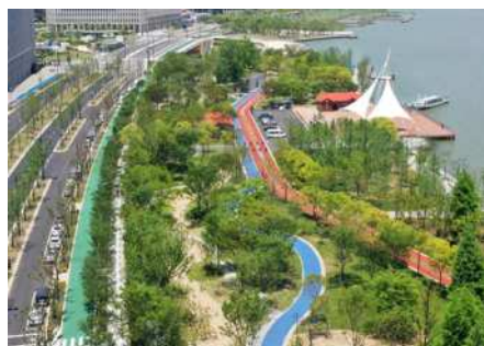
黑色透水沥青铺装机动车道及绿、蓝、红的透水铺装步道
