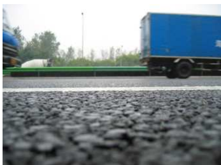
透水性沥青铺装
