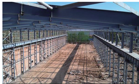
图1 建筑幕墙工程
