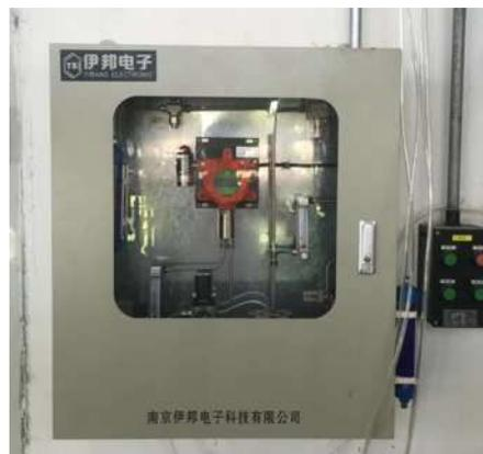
图示 车间现场光气报警器照片
