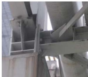
图 2 钢柱与主梁连接节点
